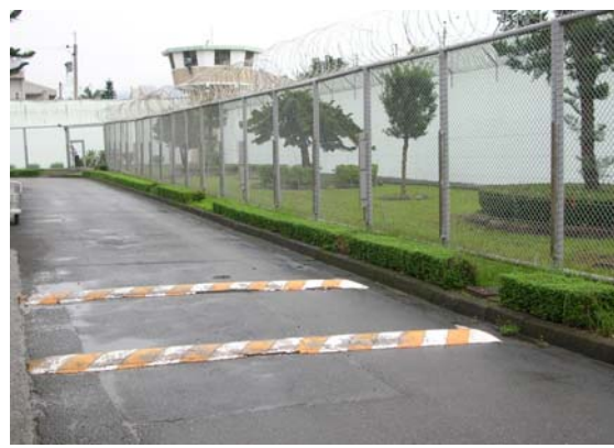
車檢站內鐵門外跳動路面
