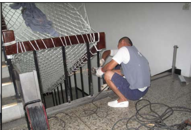
將鐵條用橫向焊接於欄杆內側
