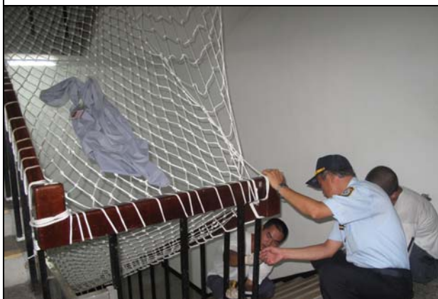
營繕組先至現場丈量欄杆尺寸
