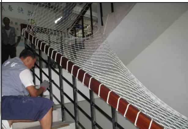
樓梯欄杆焊接完成後漆上黑色油漆
