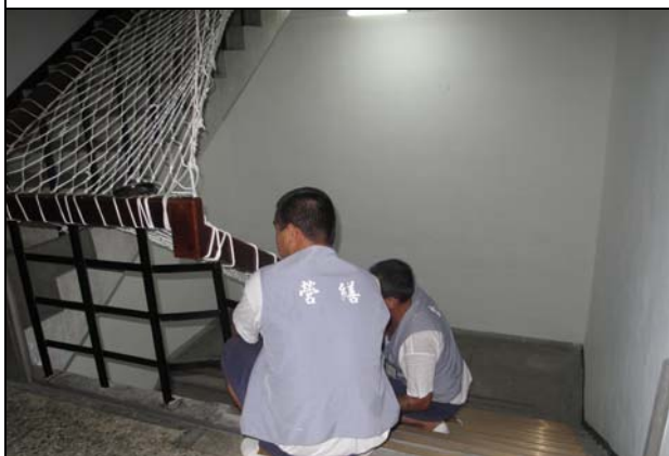
樓梯前方欄杆鐵條焊接中
