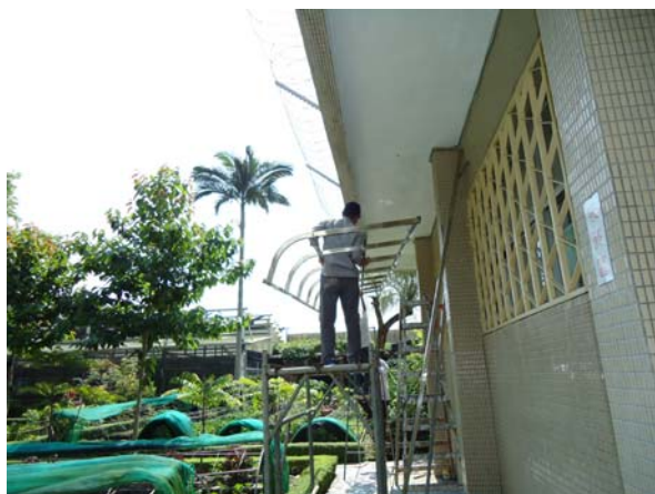
由廠商進行遮雨棚施工
