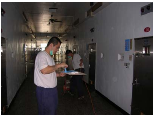
木工班施工裝設舍房牌框架
