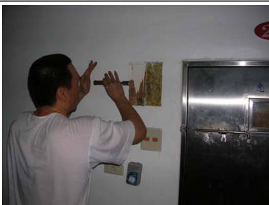
去除原有舍房牌框架
