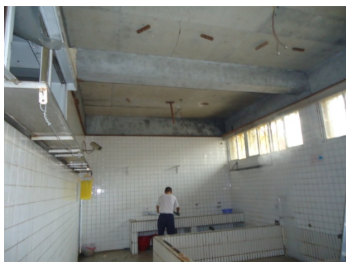
浴室天花板改善
