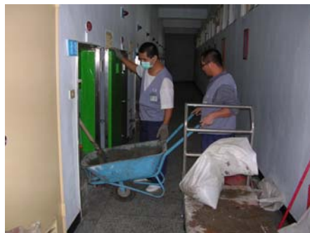
砂石水泥預拌鋪設
