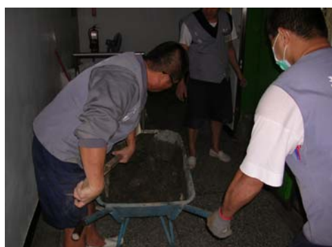
鋪設用水泥預拌
