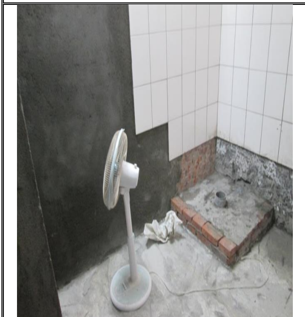
更衣室廁所泥作施工
