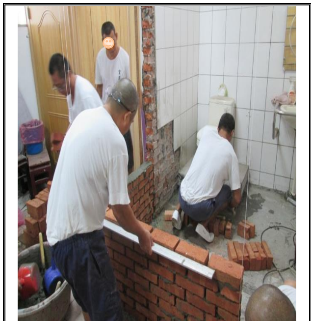
更衣室廁所牆面施工
