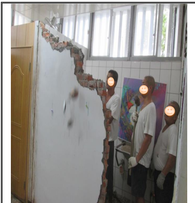
更衣室廁所原牆面打除
