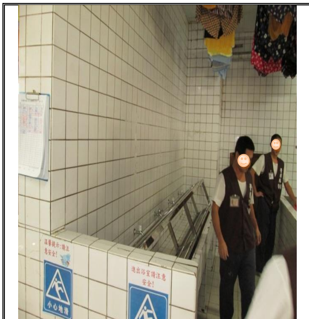
工場浴室置物架安裝前
