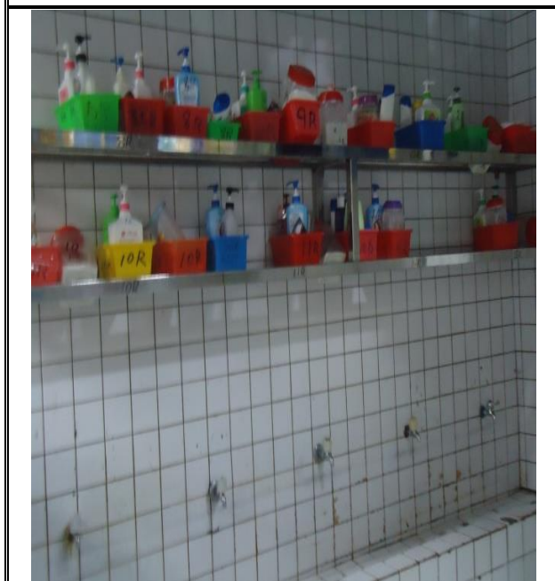
工場浴室置物架安裝完成
