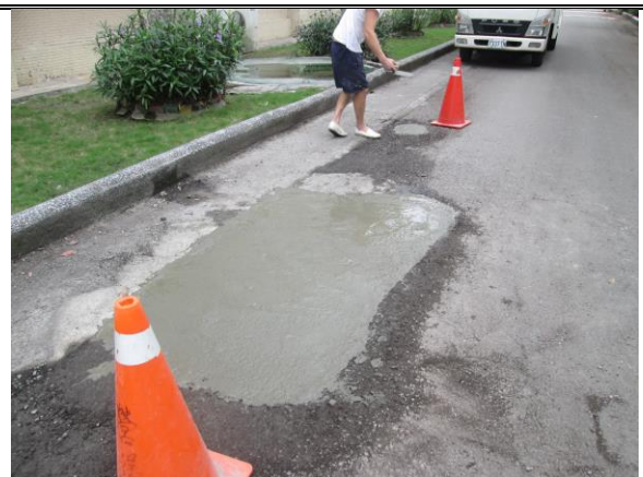
完成鋪路作業
