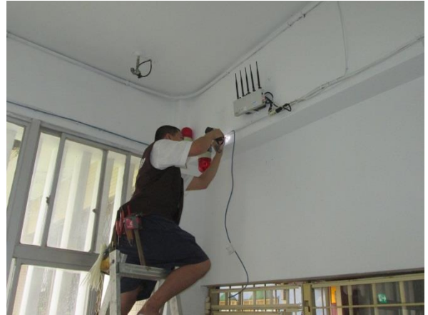
各舍房安裝情形
