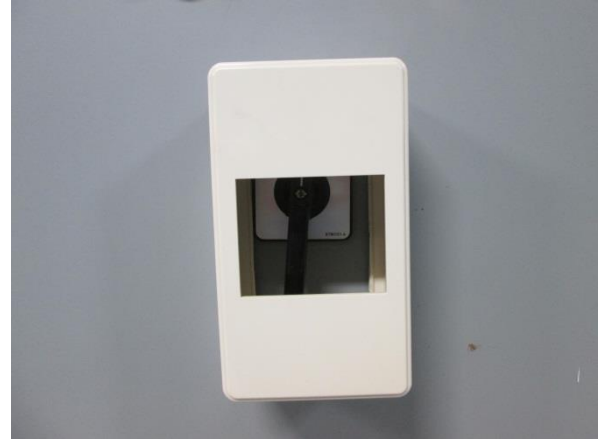
保護器加裝完成
