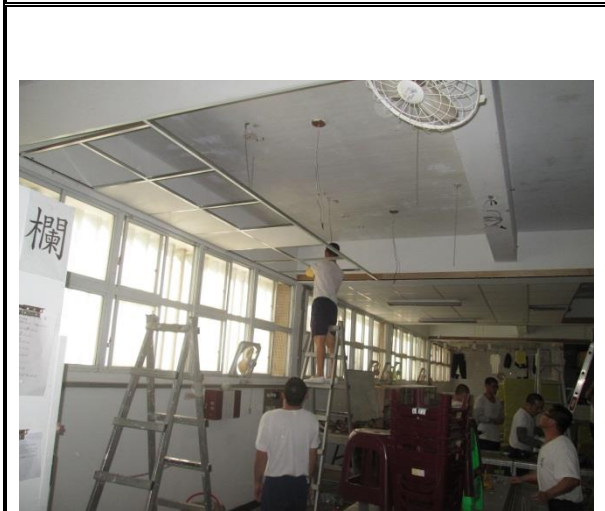
加裝天花板過程
