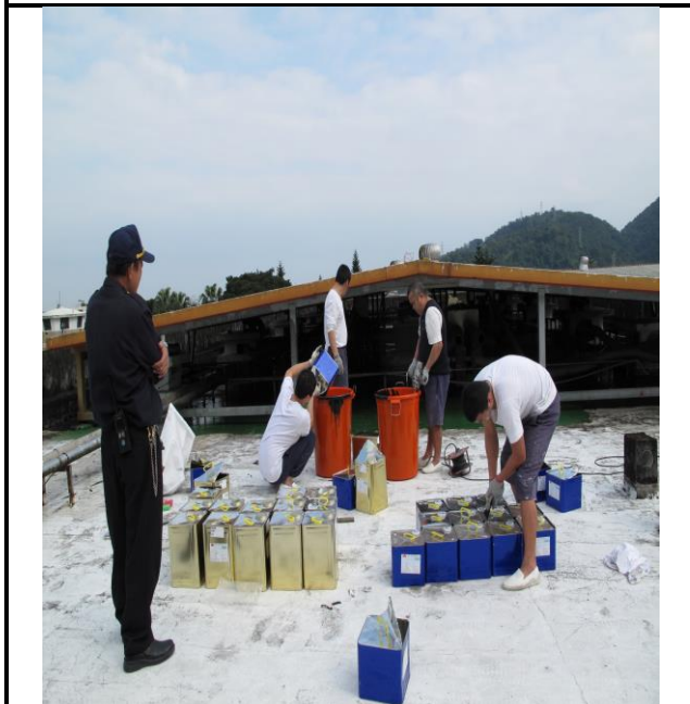
攪拌中材待鋪設
