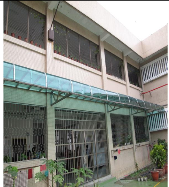
遮雨棚汰舊換新後
