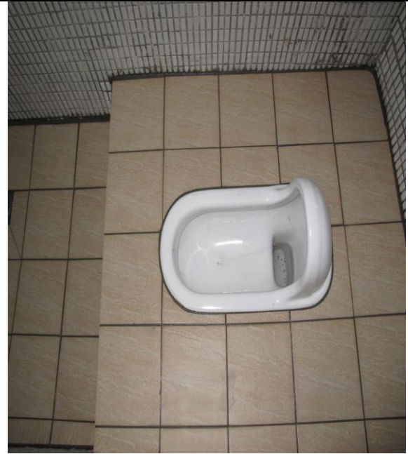
舍房浴廁防滑磁磚汰換後
