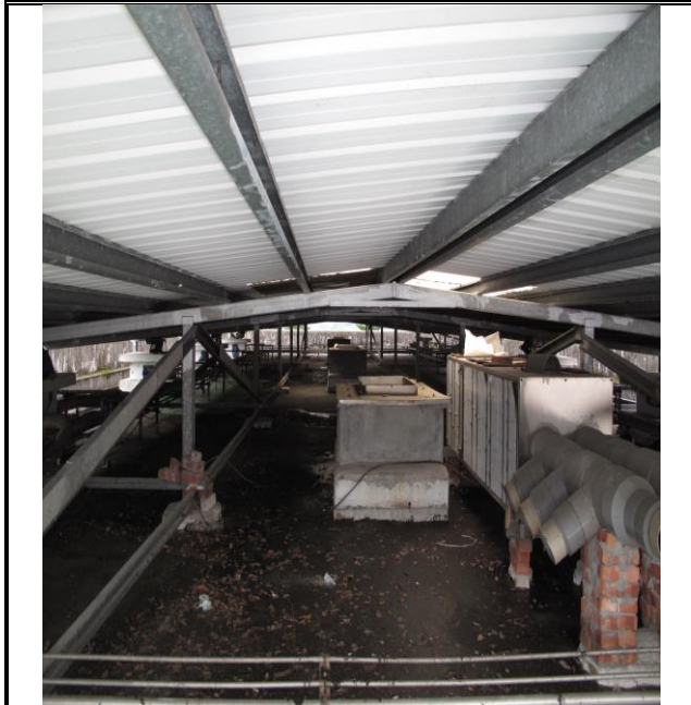
頂樓地面施工前
