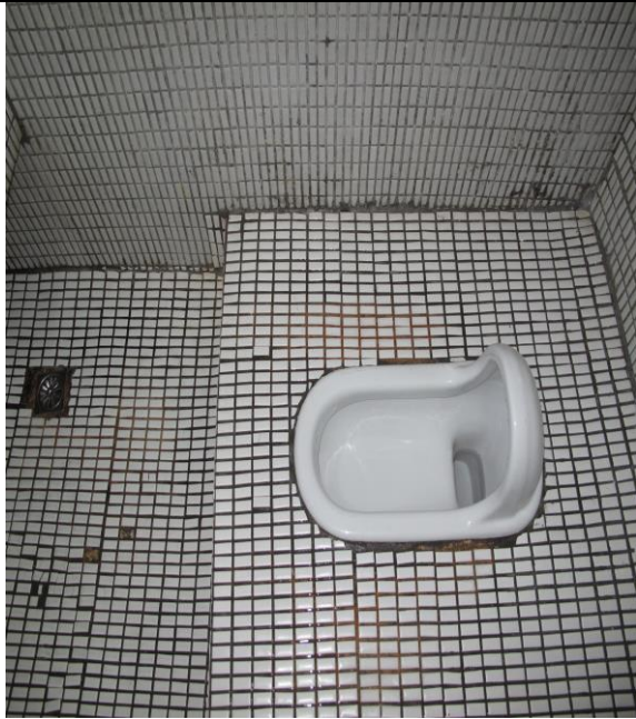
舍房浴廁磁磚汰換前
