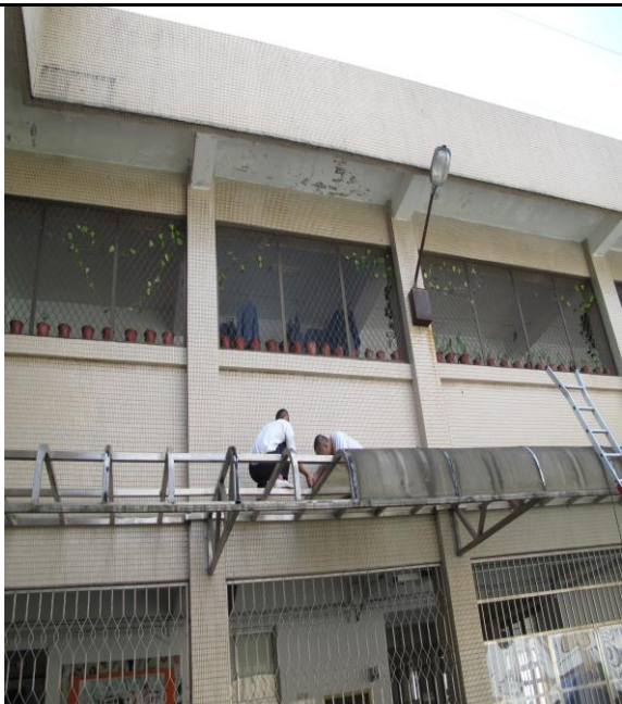
將舊遮雨板拆下
