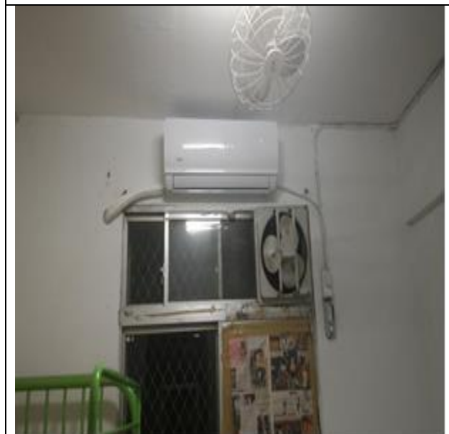
替代役隊部安裝冷氣機完成圖
