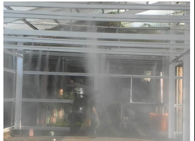
噴霧係統裝設試用效能完成圖
