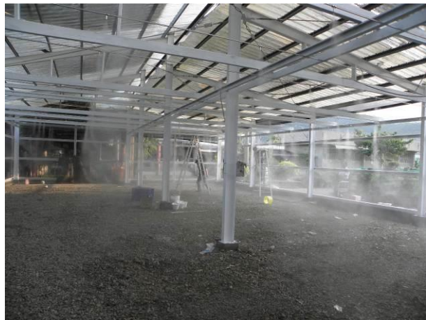
噴霧係統裝設試用效能
