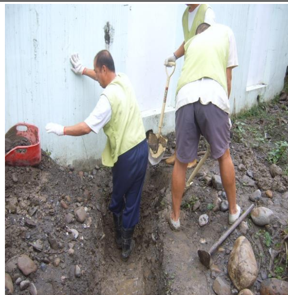
配管前挖土方。
