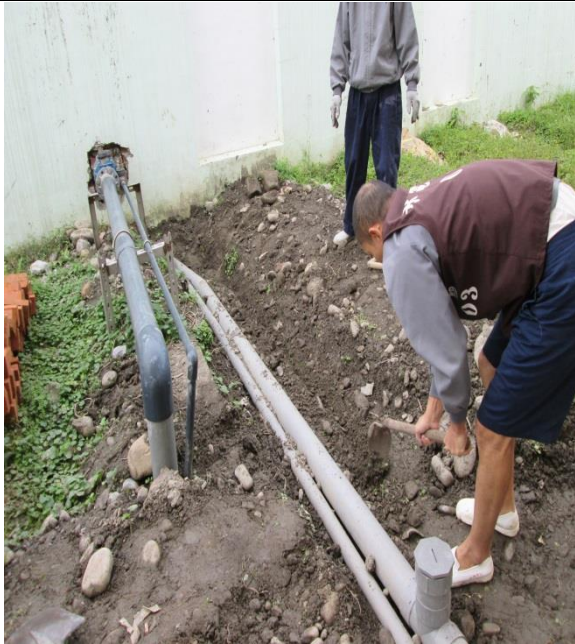
污水管線重配。
