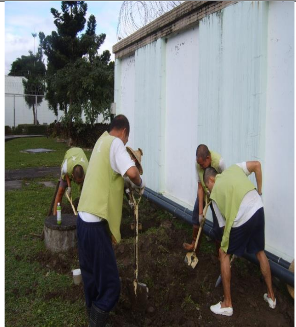
配管前挖土方。
