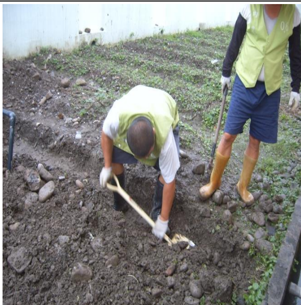
配管前挖土方。
