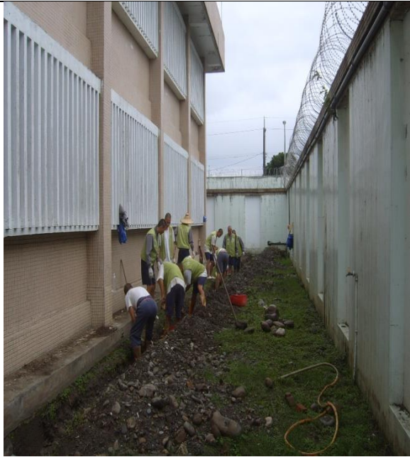
配管前挖土方。
