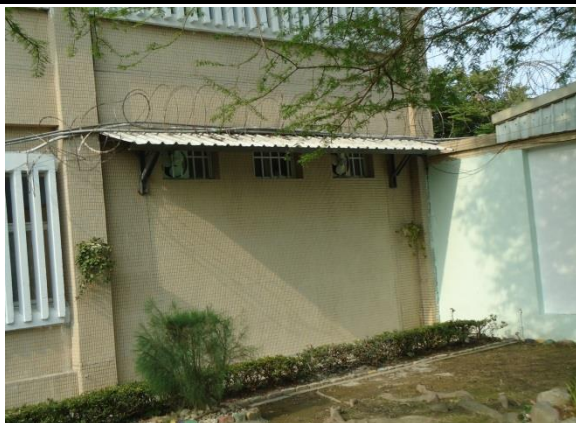
戒護科庫房南側完成照片。
