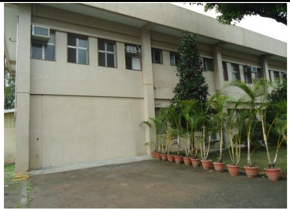
戒護科庫房北側完成照片。
