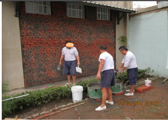
牆面砌磚施工。
