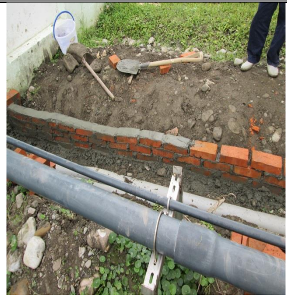
完成管線配置。
