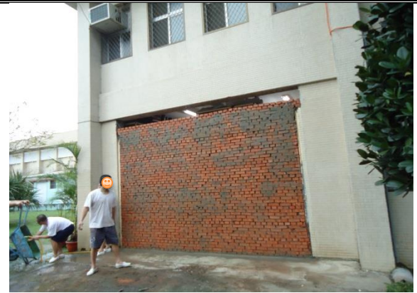
牆面砌磚施工。
