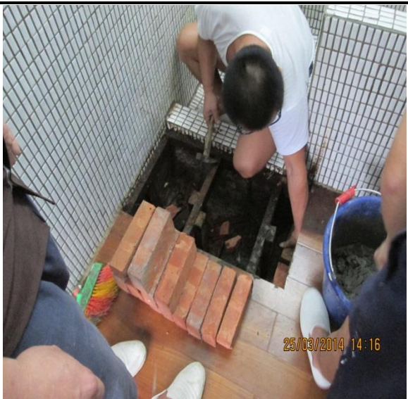
重新鋪設水泥地板中。
