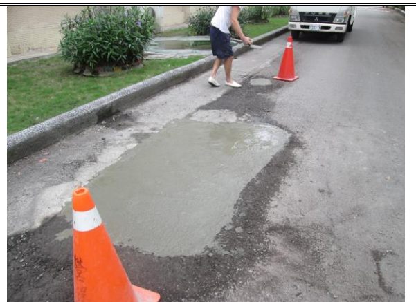
完成鋪路作業
