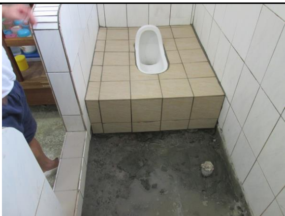
完成廁所新瓷磚
