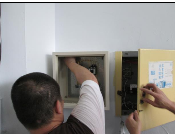
將部份電線配置至第三配電箱
