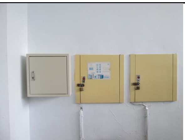
完成配電箱工作
