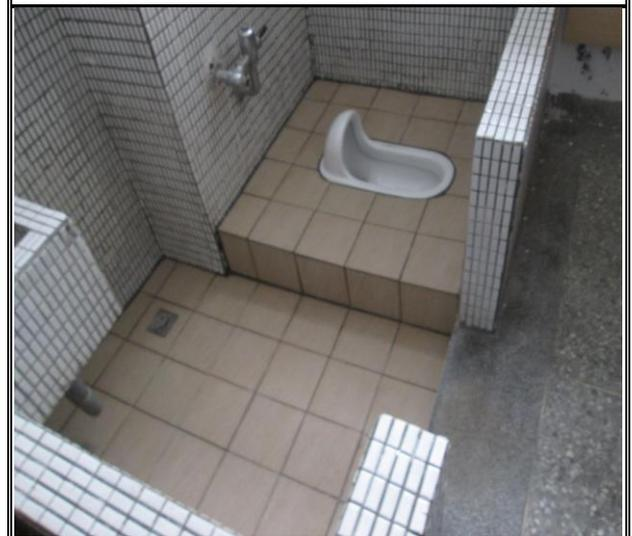
效益分析：為舍房內舊地板磁磚濕滑容易造成如廁時滑倒而衍生為戒護事故，另改善後整齊美觀，本監營繕組為刨除舊磁磚並跟新鋪設止滑磁磚。
